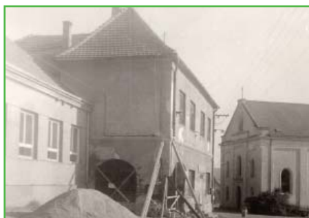
Budova MNV po dopravní nehodě
