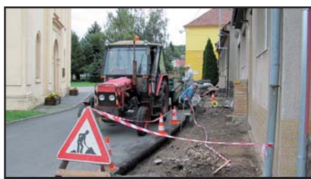
Oprava chodníku před kostelem
