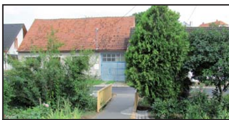
Oprava mostku před Proškovým
