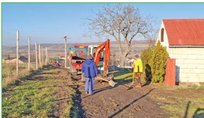
Úprava cesty za 3. řádkem.
