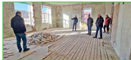
Rekonstrukce budovy obecního úřadu.
