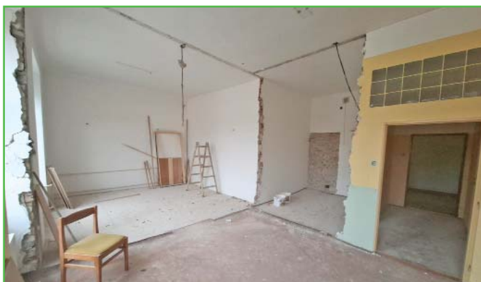
Rekonstrukce OÚ bourací práce 2. NP
