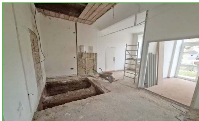
Rekonstrukce OÚ bourací práce 1.NP
