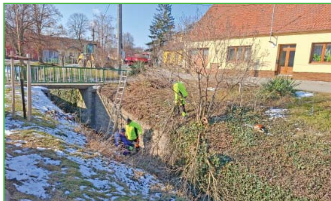
Čištění koryta potoka.
