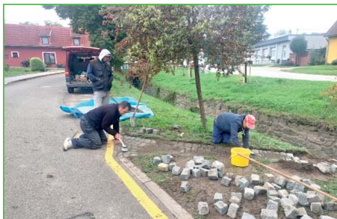
Stavba odtokového žlabu.
