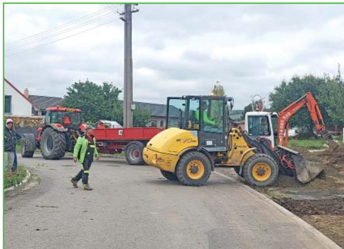
Stavba chodníku na 0. řádku.
