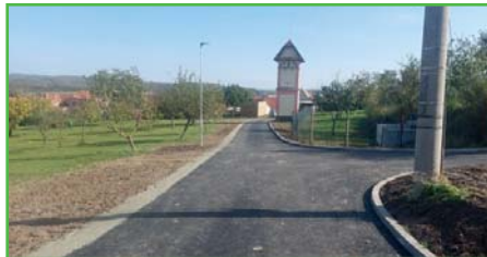
Dokončená část spojovací uličky
