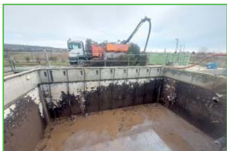
Vývoz sedimentů z ČOV
