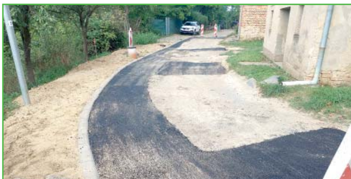
Dokončení komunikace na 2. řádku sklepů
