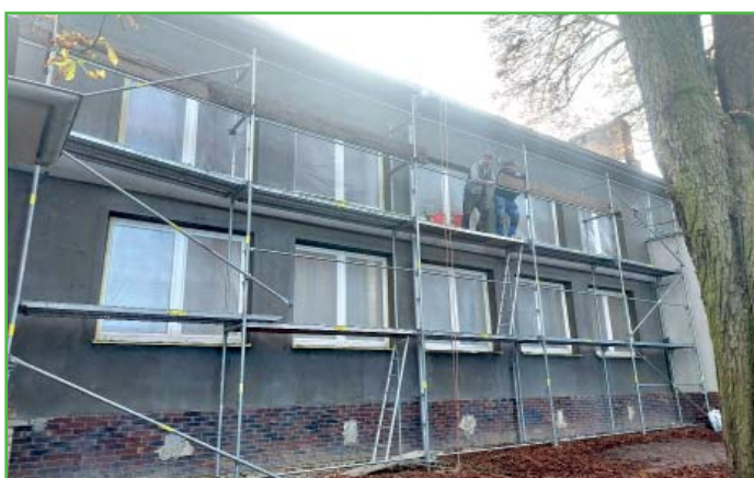
Oprava fasády sokolovny
