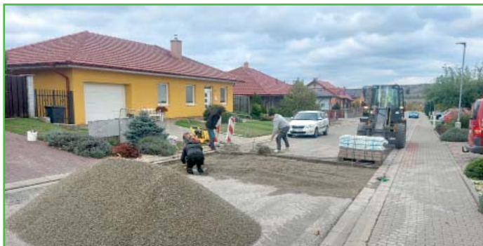
Stavba zpomalovacího retardéru na 4. řádku
