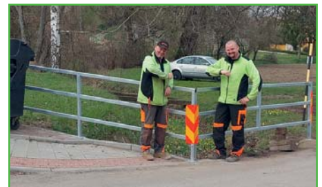
Oprava zábradlí mostku
