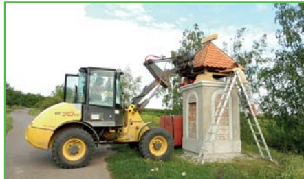
Stavba kapličky v terasách
