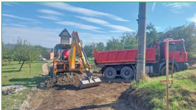
Budování nového chodníku.
