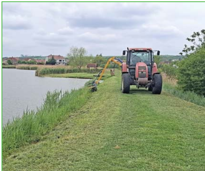
Sečení hráze příkopovým ramenem.
