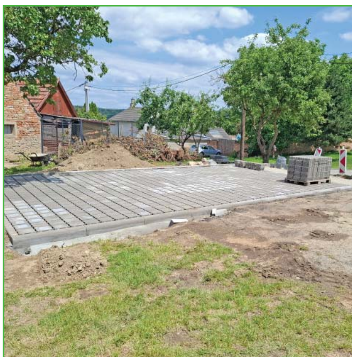
Stavba parkoviště u hřbitova.
