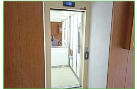
Výtah na OÚ.
