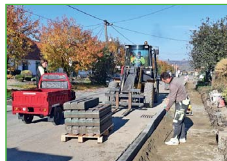
stavba chodníku na 3. řádku
