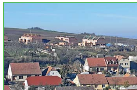
postupující výstavba RD
