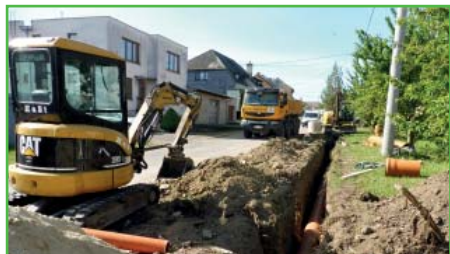
Firma Hast při rekonstrukci dešťové kanalizace
