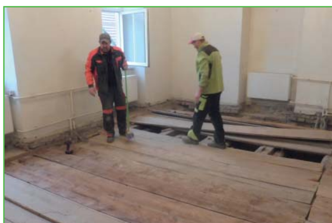
oprava dřevěných konstrukcí
