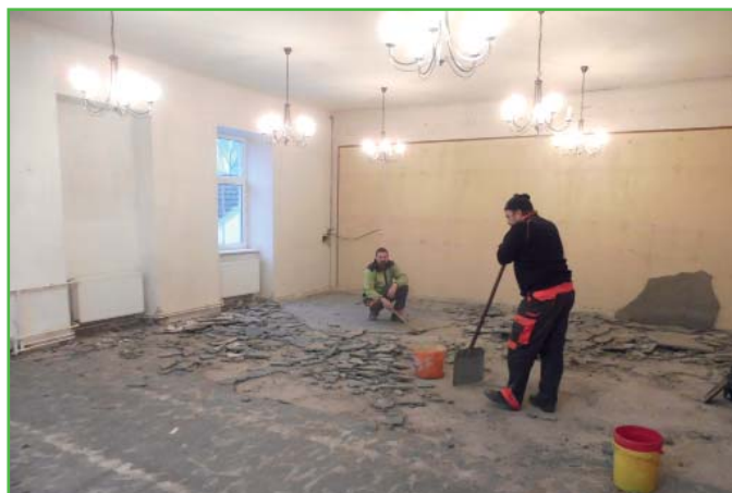
bourání starého stropu
