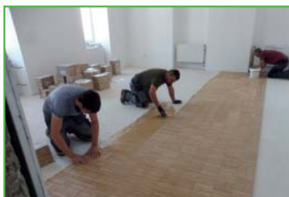
pokládka dubové podlahy
