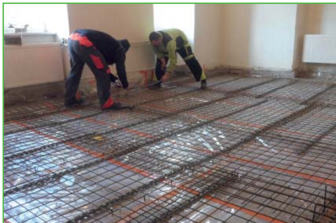
výztuha nového stropu
