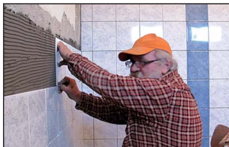
Rekonstrukce soc. zařízení sportovních šaten
