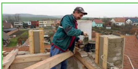
Oprava věže hasičky - výstavba pilířků
