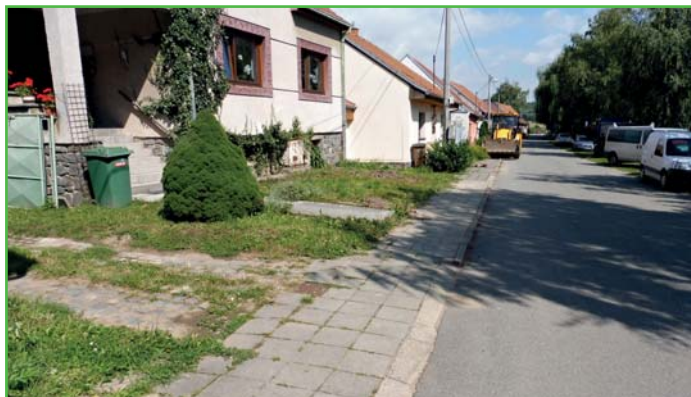
Chodník 2. řádek před rekonstrukcí
