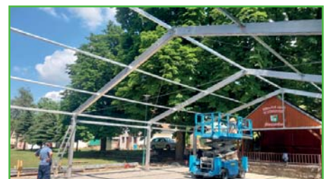
Stavba zastřešení tanečního parketu.
