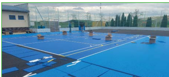
Pokládka povrchu bergamo.
