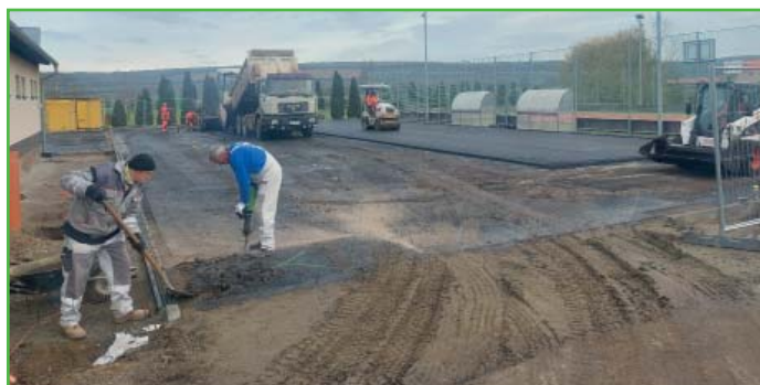
Foto ze stavby hřiště.
