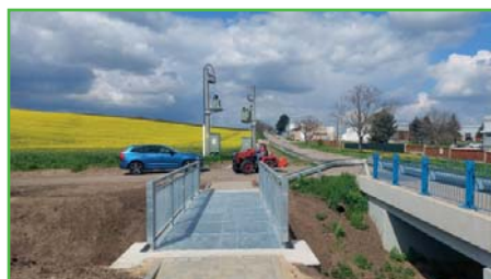
Mostek pro pěší na novém chodníku do průmyslové zóny.
