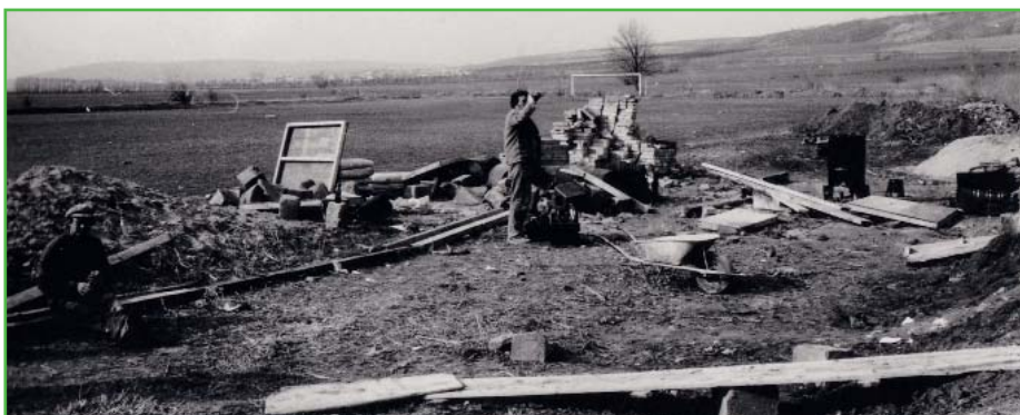
1982 Začátek stavby fotbalových kabin v první polovině 80. let.
