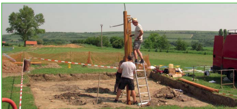
2013 Stavba dětského hřiště.
