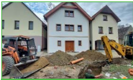
Stavba vodovodu a kanalizace mezi sklepy.
