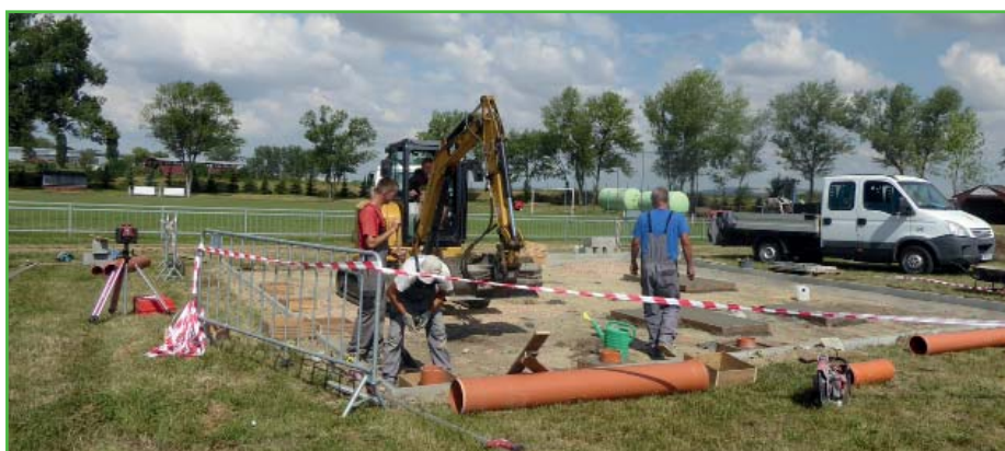
2018 Stavba parkourového hřiště.
